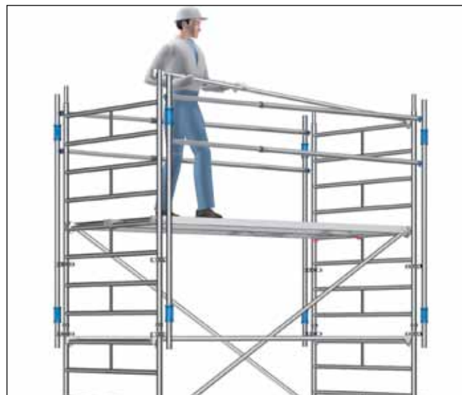
Fig. 6: Montøren er sikret mot fall ved bruk av Monteringsrekkverk.
