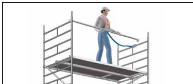
Fig. 3: Montøren er sikret mot fall ved bruk av sikkerhetssele og line med karabinkrok.
